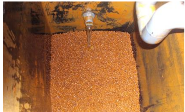
Figuur 18: Fosfaatfilter op basis van ijzerkorrels
