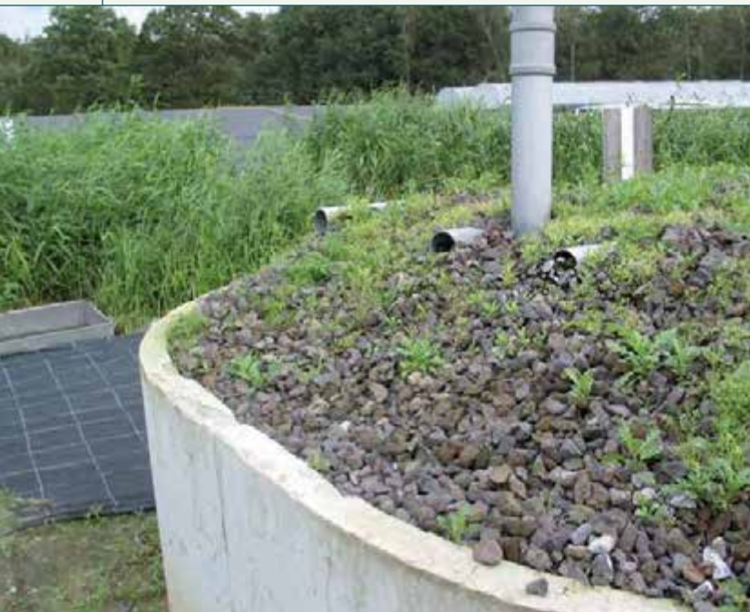
In de lavafilter op het Proefcentrum Hoogstraten, die onderdeel is van het rietveldencomplex, vindt nitrificatie plaats en wordt een belangrijk gedeelte van de nog aanwezige organische stof afgebroken.
