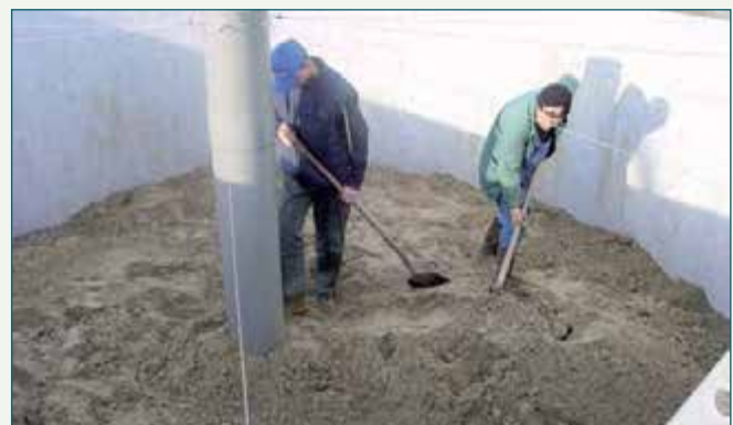
Opbouw van een langzame zandfilter
