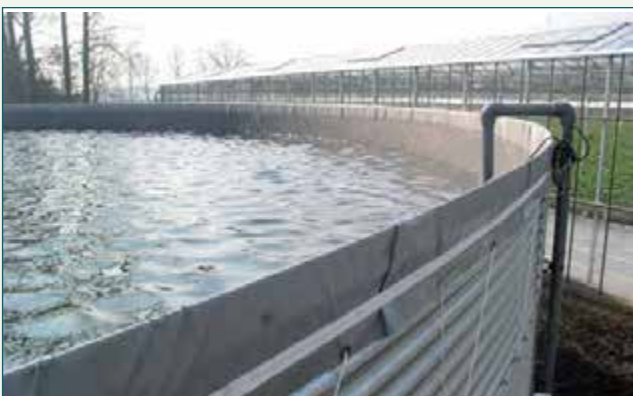
Voor opslag van regenwater worden watersilo's of foliebassins gebruikt. Een watersilo neemt minder plaats in dan een foliebassin, maar is over het algemeen duurder dan een foliebassin.
