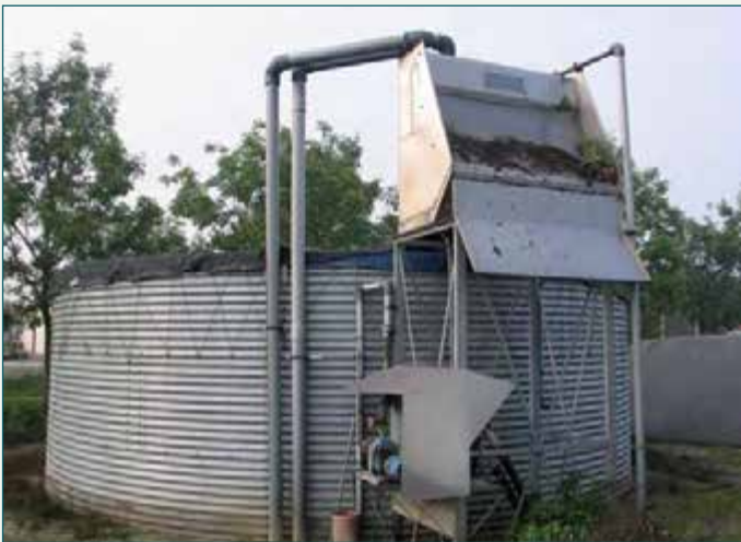
Bij sommige teelten wordt een zeefbocht gebruikt om het water voor te filteren en zo te ontdoen van grof organisch materiaal vooraleer het te ontsmetten met een langzame zandfilter.
