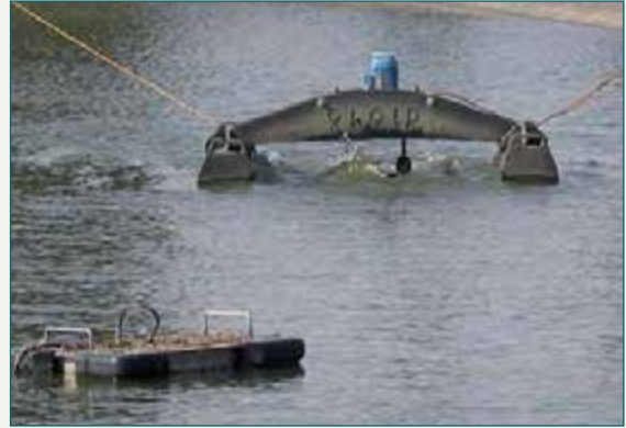
Soms wordt een beluchter samen met een ultrasoon-toestel tegen algen ingezet.
