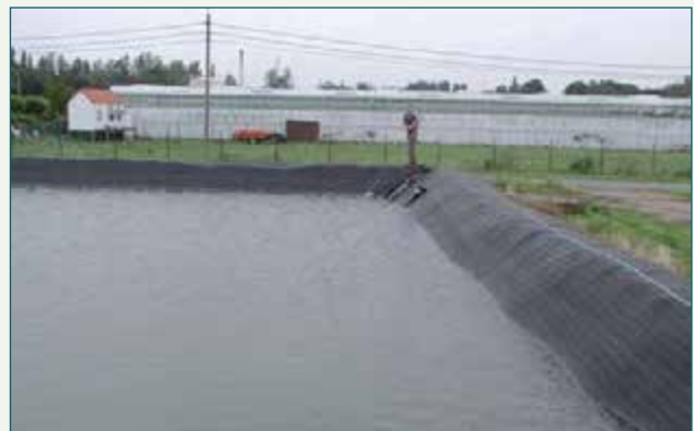
Voor opslag van regenwater worden watersilo's of foliebassins gebruikt. Een watersilo neemt minder plaats in dan een foliebassin, maar is over het algemeen duurder dan een foliebassin.
